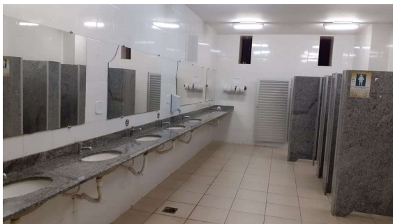
Figura 3: Banheiro Masculino Executado. Fonte: Autores
